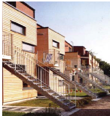
Varje enhet i lamellhusen har egen entré utifrån. Trappan till etage-lägenheterna ansluter till en entrégård mot väster. Inspirationsbild: Kv Hemdal, Västerås.
